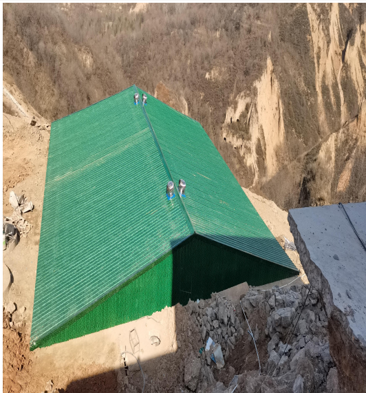
渗滤液调节池封顶
