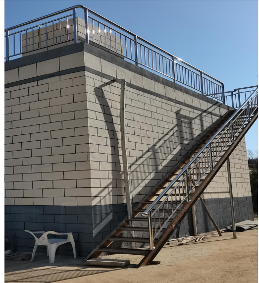
渗滤液处理站综合水池
