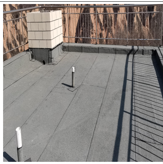
渗滤液处理站综合水池封顶
